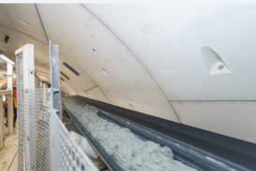
L'ensemble des chantiers du Grand Paris Express doit extraire un total de plus de 47 Mt de déblais. Ici, les déblais du tunnel du lot 1 de la ligne 18.
