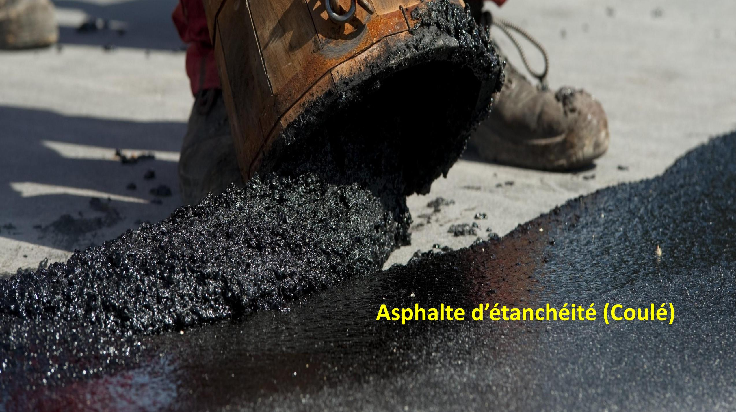
**Asphalte d'étanchéité (Coulé)**
