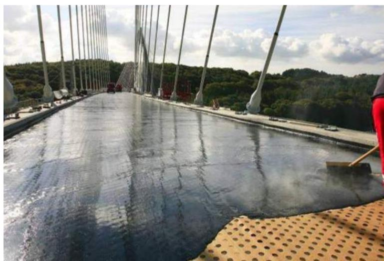
Figure 3 : AC – Asphalté étanchéité pont. Source : Site internet officiel de l'office des asphaltés
