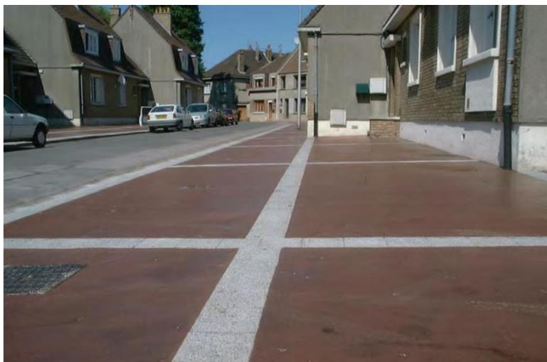
Figure 2 : AT - Asphalté trottoir à Calais. Source : Nord Asphalté
