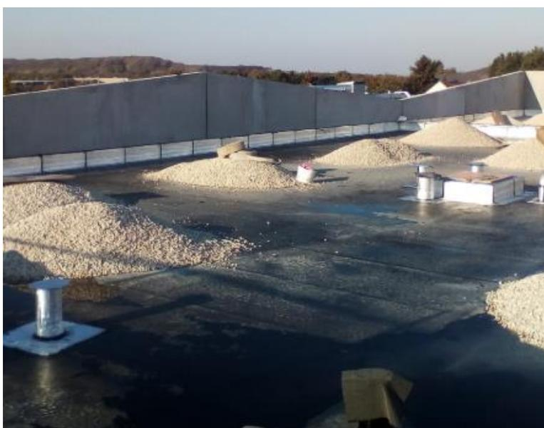
Figure 5 : AS - Asphalté bâtiment – Toiture terrasse. Source : Nord Asphalte.
