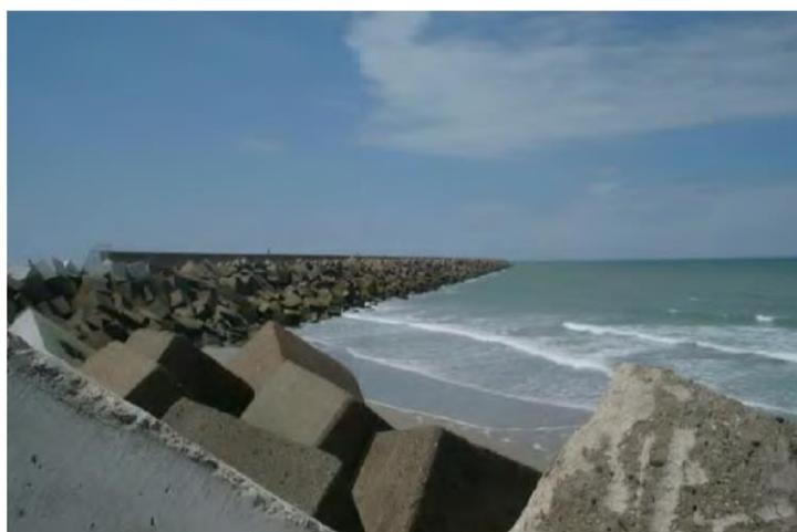
Figure 7 : AP - Digue d'engrochement – Malo les bains/Dunkerque. Sources : Nord Asphalte
